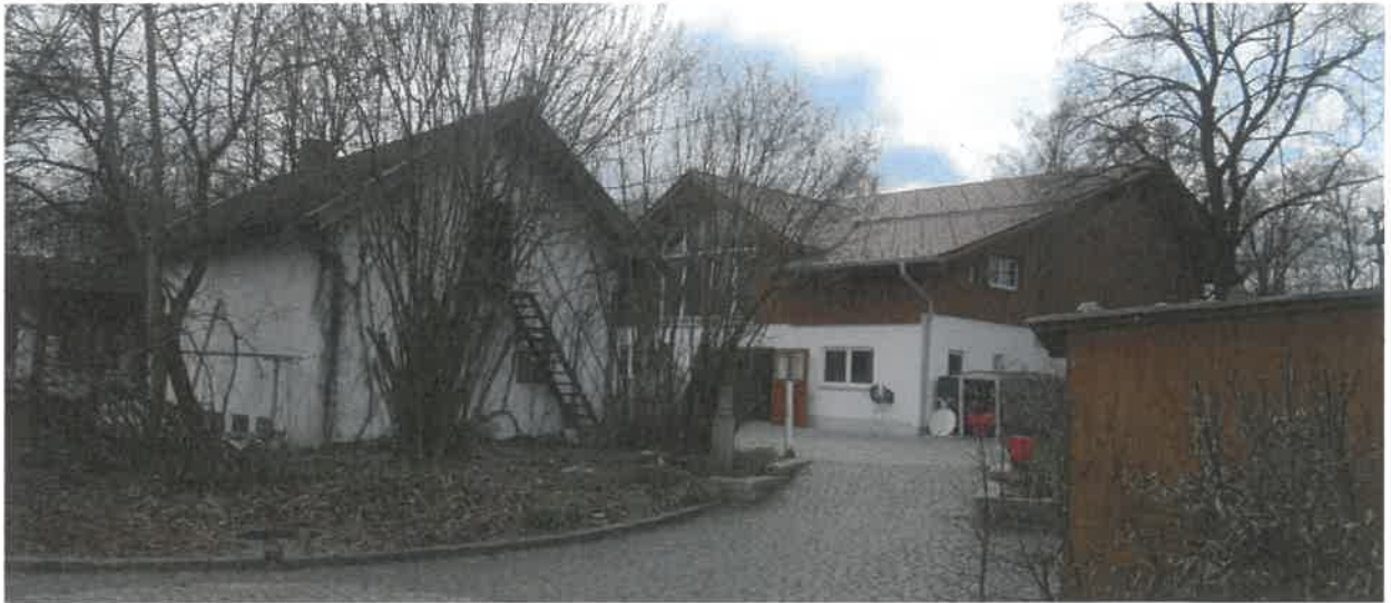
Abb. 10: Blick von Nordosten auf Garagengebäude und Wohngebäude (Hintergrund)
