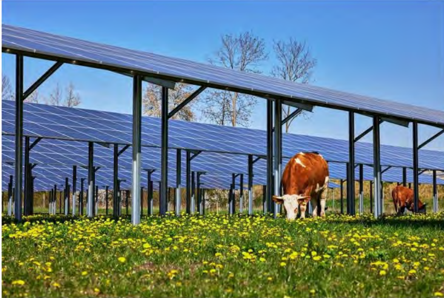
Das Bild zeigt eine Agri-Photovoltaikanlage im Landkreis Freising, unter der eine Herde Rinder graszt. Bildquelle: OneSolar International GmbH; https://www.onesolar.de/geschaeftsfelder/agri-pv/
