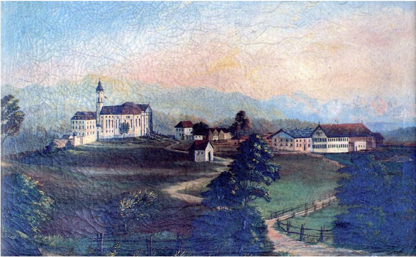
Abbildung 21: Ansicht der Wieskirche von Nordosten, anonymes Ölgemälde des 19. Jahrhunderts
