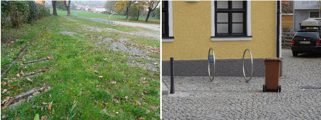
Abb. 43: Anlage in einem sehr schlechten Zustand (Wellenfreibad, linkes Bild) und qualitativ gute Anlage (Rathaus, rechtes Bild)
