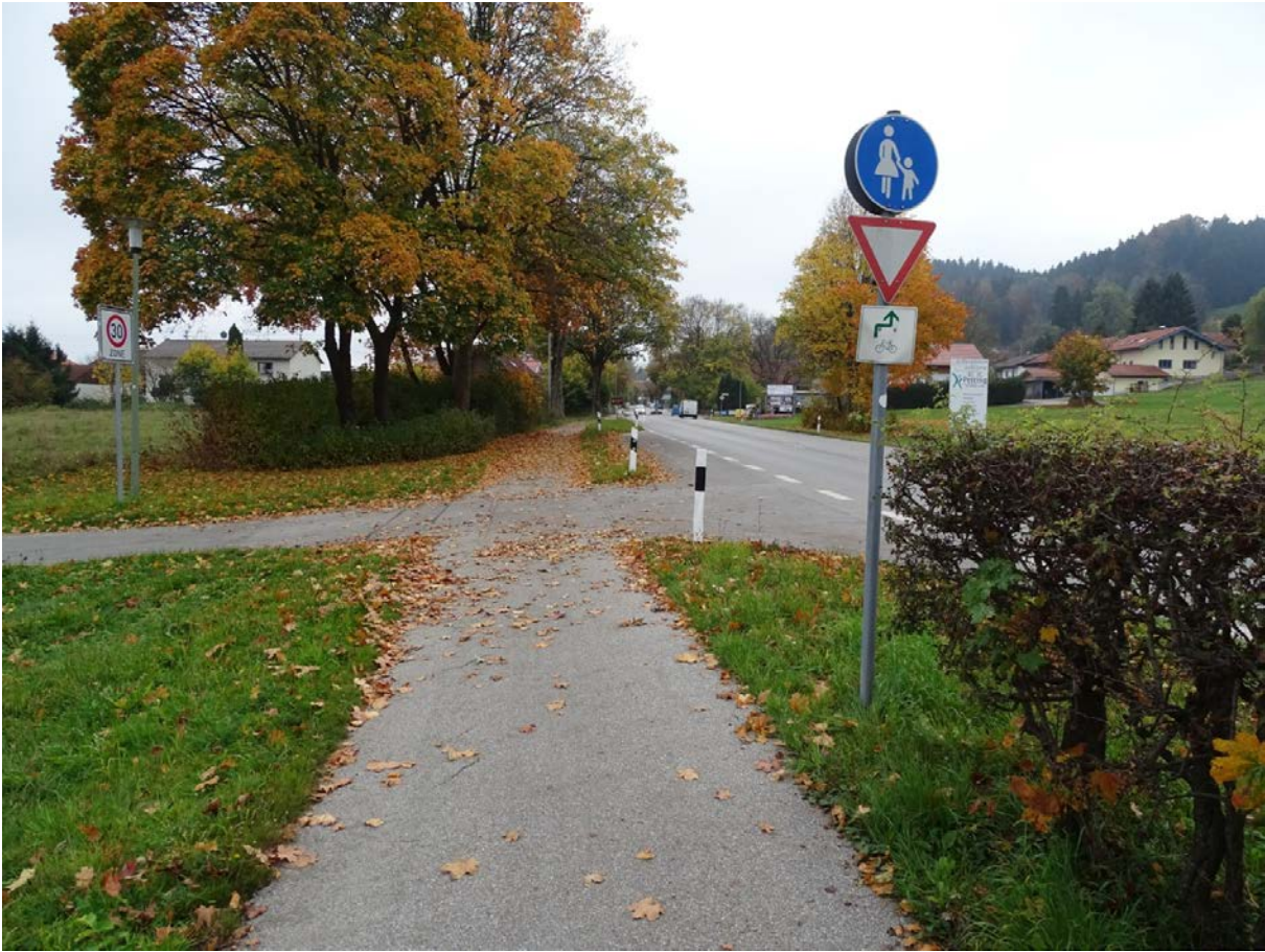
Abb. 38: Eingeschränkte Sicht an einem Netzknoten und Überleitungsbereich durch Bewuchs
