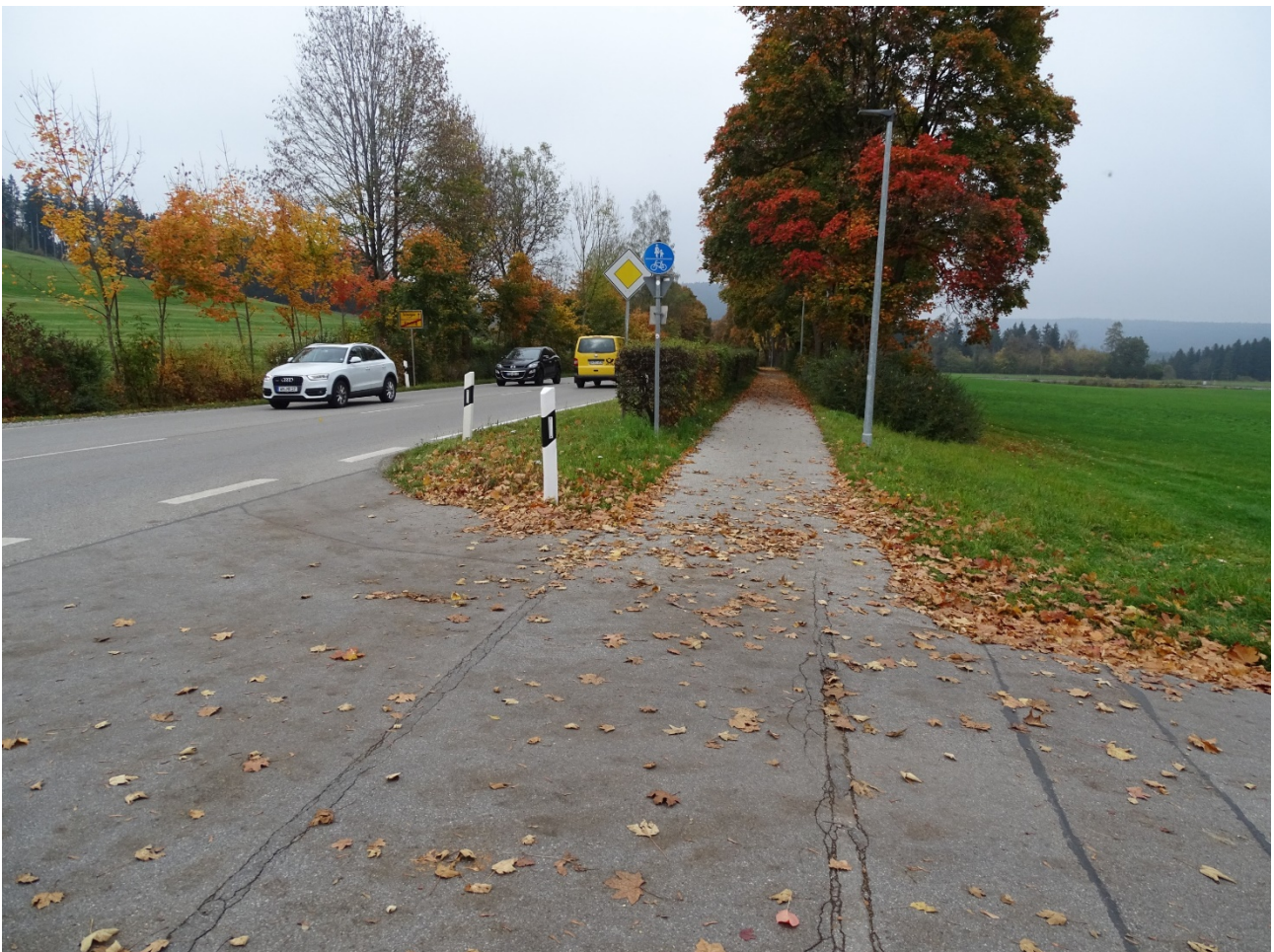
Abb. 35: Fehlende Kennzeichnung eines 2-Richtungsradweges
