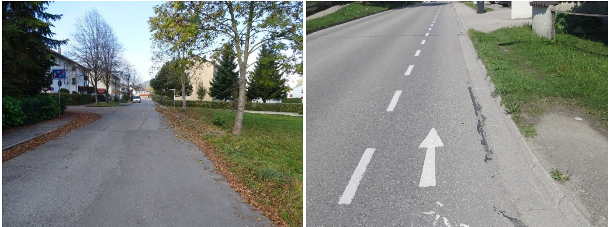
Abb. 29: Entspricht nicht den Anforderungen an qualitativ hochwertige Radverkehrsanlagen: Die Führung innerhalb eine verkehrsberuhigten Bereiches (links) und eine nur einseitige Sicherung (rechts)
