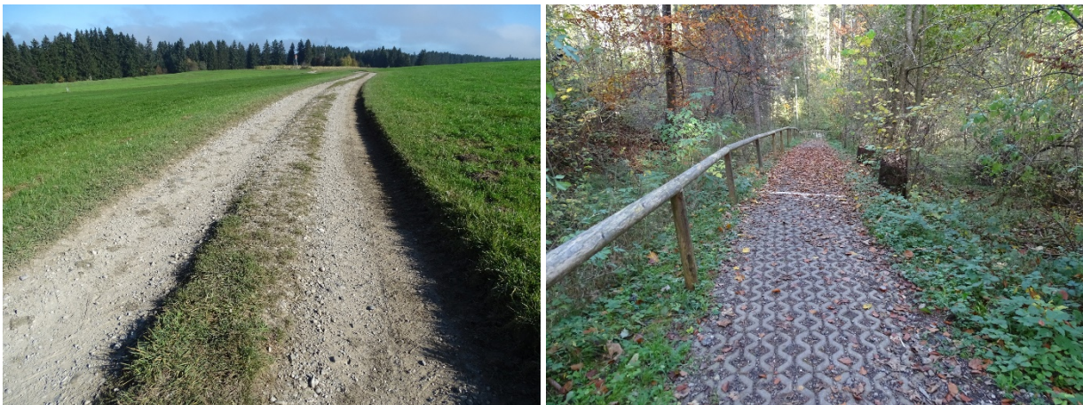
Abb. 32: Netzelemente mit nicht ausreichender Oberflächenbeschaffenheit: tiefe Furchen im Weg (links) und schlechter Zustand eines befestigten Weges (rechts)
