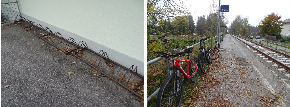
Abb. 45: Nicht mehr zeitgemäße und z.T. beschädigte Felgenhalterungen (FA Peiting, linkes Bild) und fehlendes Angebot am Bahnhof Nord (rechts)
