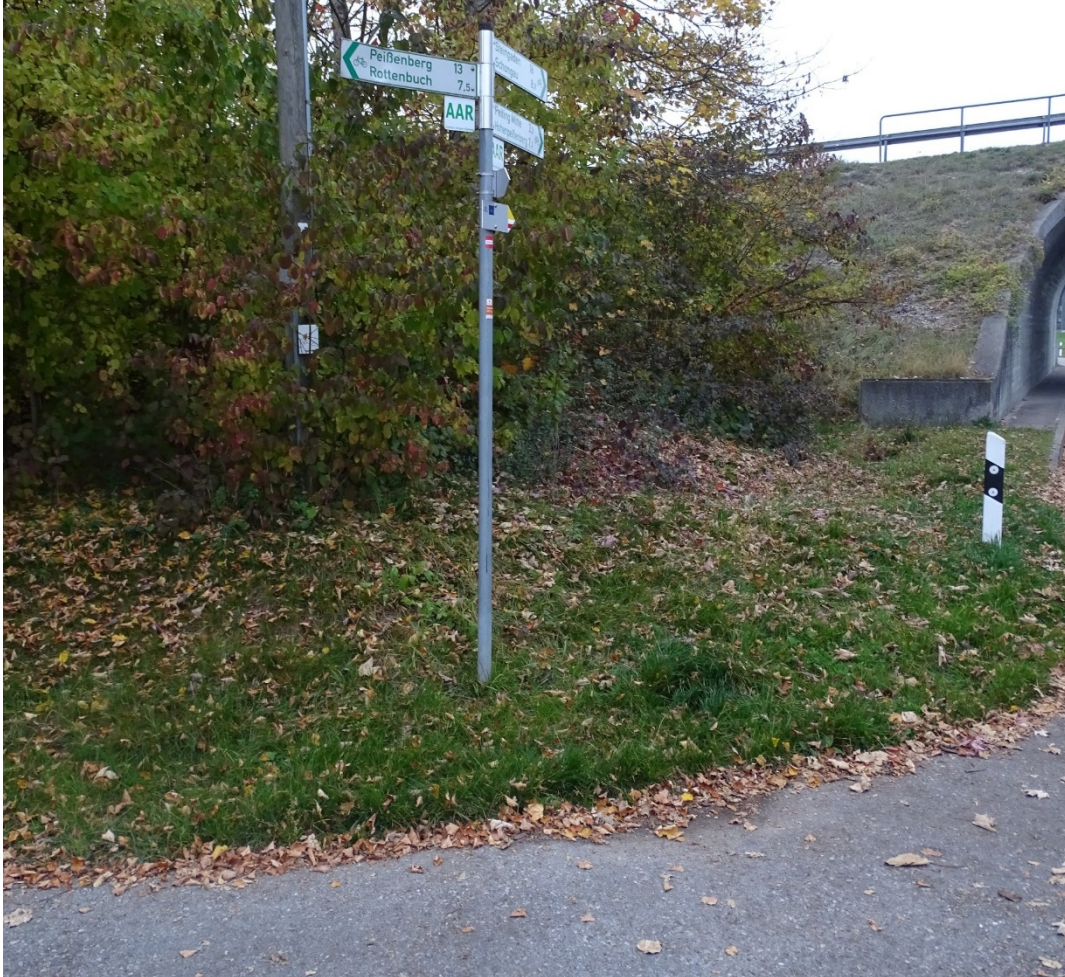
Abb. 33: Falsch ausgerichteter Zielwegweiser
