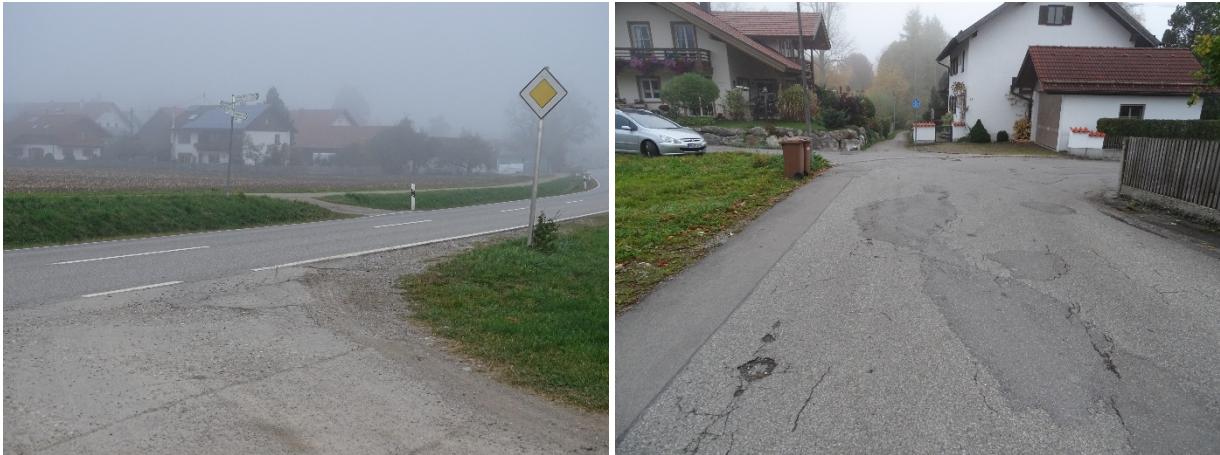
Abb. 39: Fehlende Querungshilfe an einem Knoten (links) und Sicherheitsrisiko aufgrund eines ungünstigen Winkels beim Befahren einer Überleitung in den Seitenraum (rechts)
