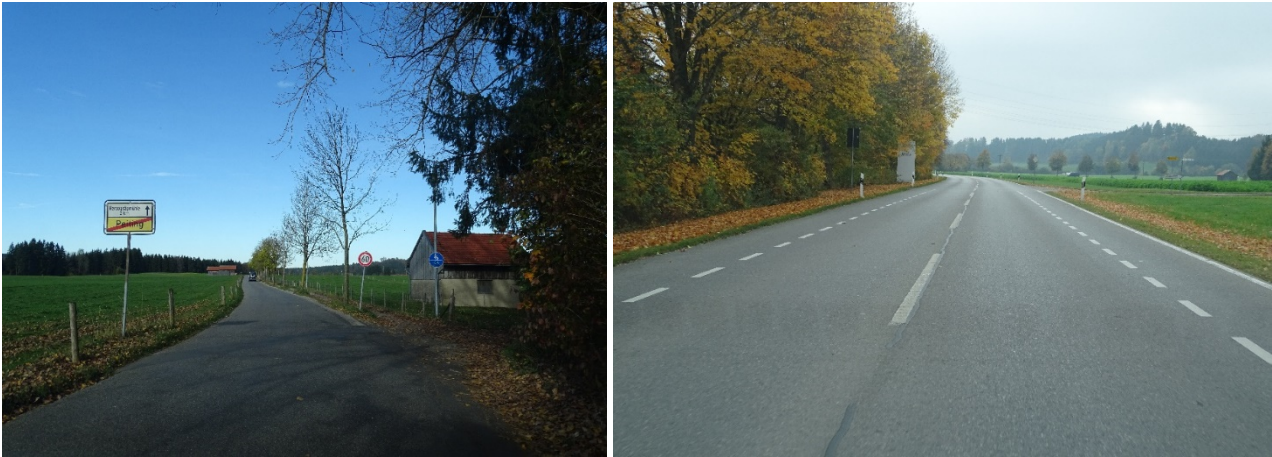
Abb. 31: Zu schmal dimensionierter Radweg (links) und Breite des Schutzstreifens entspricht den Regelwerken (rechts)
